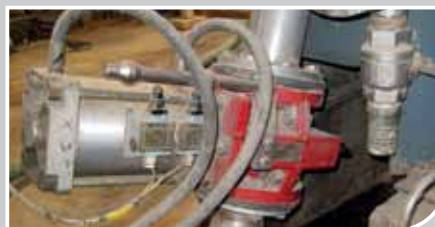
Пережимные клапаны Flowrox на заводе "GIIC"
